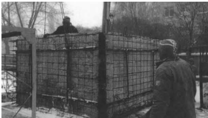
Рис. 3. Подготовленные к монтажу цельносекционные блоки
