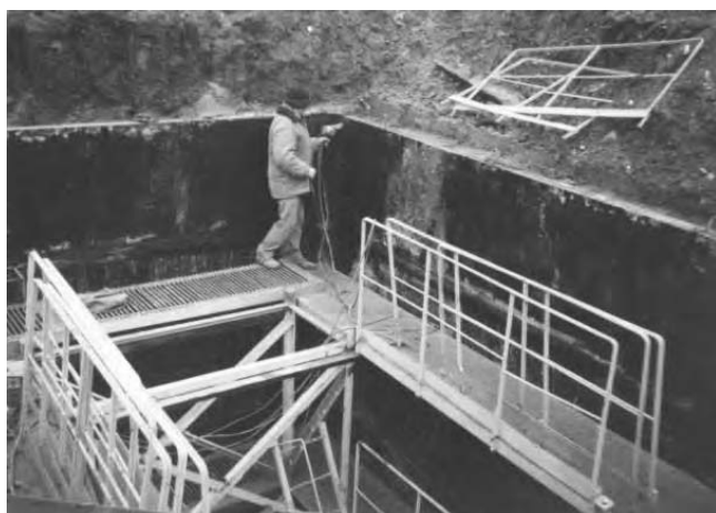
Рис. 4. Сваривание стыков профилированного полиэтилена
