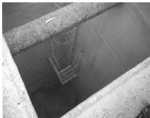
Рис. 5. Шахта после восстановления панелями, облицованными ребристым полиэтиленом
