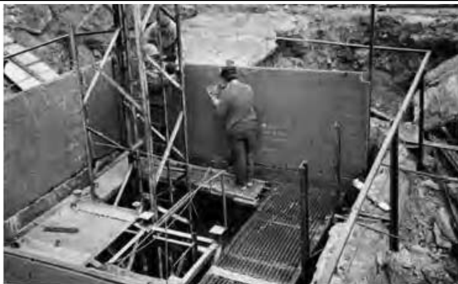
Рис. 6. Общий вид обустроенной строительной площадки смотровой шахты в процессе монтажа шлаколитых панелей
