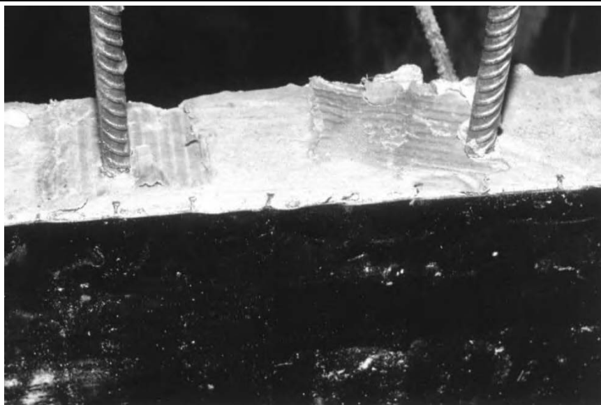
Рис. 2. Обеспечение сцепляемости бетона и полиэтилена
